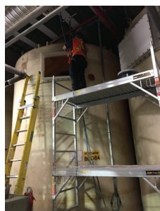
Réparation et modifications de réservoirs telles que : l'installation d'une trappe d'accès, de raccords de type NPT ou à brides, de supports ou de ponts pour agitateur, etc.
