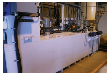
Système de mise en solution de polymère sec avec pompes doseuses
