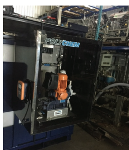
Cabinet de système de dosage de produit dangereux avec porte en acrylique
